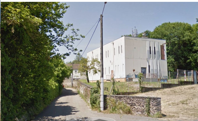
Bâtiment technique d'EDF
